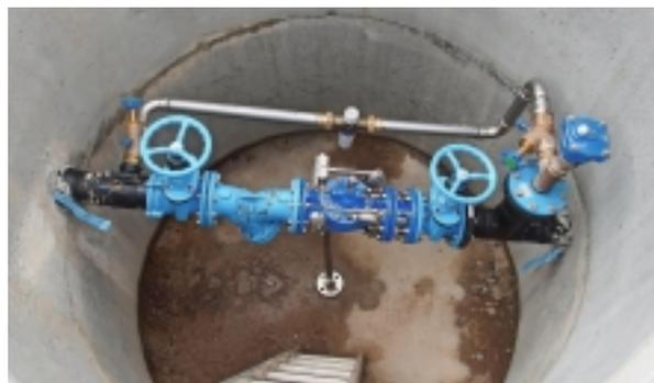
Druckreduzierventil MV1 Mutte/Zusli
