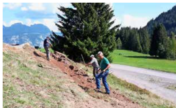
Grabarbeiten für die Betriebswarte
