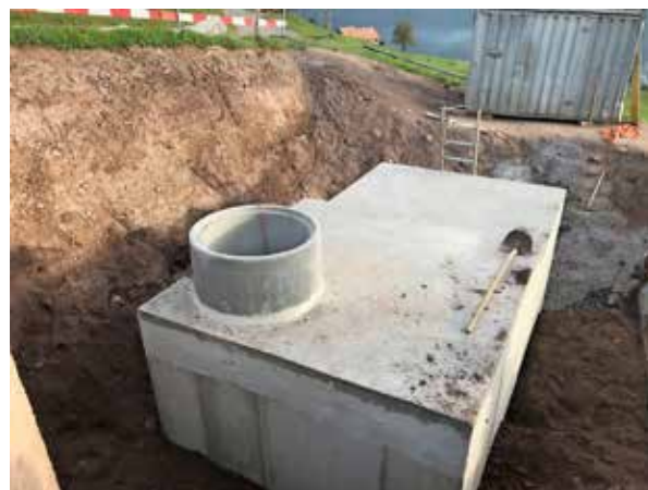
Neu erstellter Druckbrecherschacht CS1
