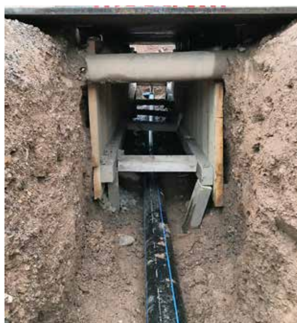
Leitungsunterquerung Flumserbergstrasse
