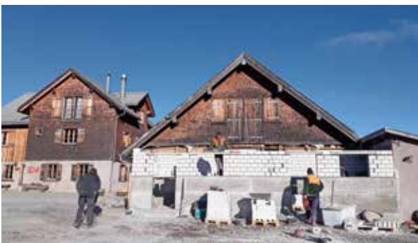
Bauarbeiten im Spätherbst
